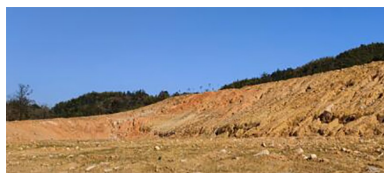
图 2 清表后堆渣场地水土流失
