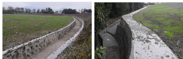
图 5 利用弃渣修筑排水沟及挡墙
