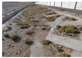
(b) 霍尔 220 kV 变电站植物护坡
