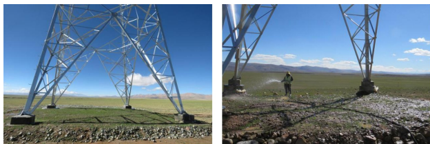
(a) 霍巴 I 线 102 号塔植被恢复效果 (b) 霍巴 I 线 118 号塔人工洒水浇灌
