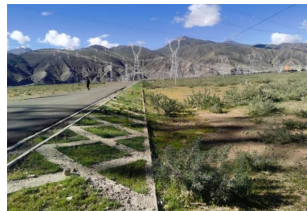
(a) 查务 500 kV 变电站植物护坡
