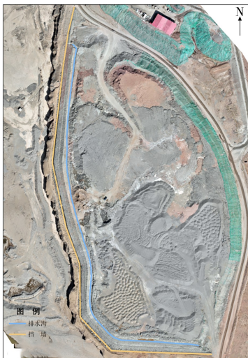
图 8 通过 ArcMap 测量 2 号弃渣场挡墙和排水沟指标
