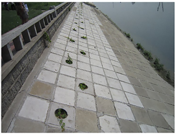
图2 预制混凝土种植穴结合植物护坡实地照片(清河南镇段)
