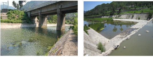
(a) 永定河下马岭段 (b) 永定河斋堂段
