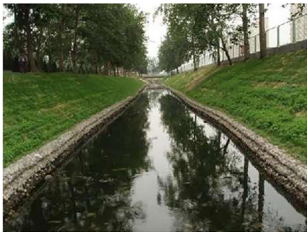
图 6 生态植被毯结合植物护坡实地照片(凉水河人民渠段)
