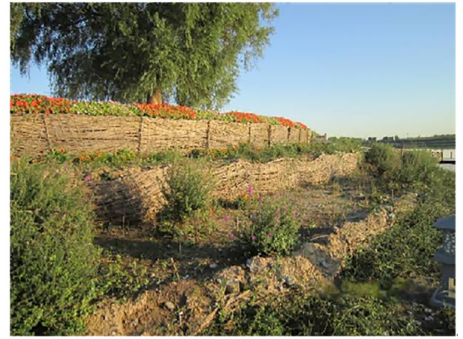
图 7 木桩枝条联排结合植物护坡实地照片 (北运河通州滨河森林公园段)
