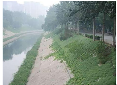
图4 坡改平生态砖结合植物护坡实地照片
