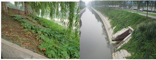
图 5 三维网植灌草护坡实地照片 (小月河中国农业大学东校区段)
